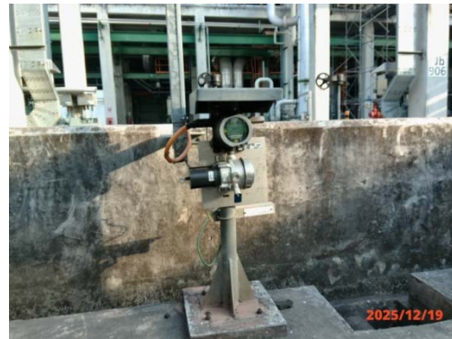
รูปที่ 49 Gas Detector
