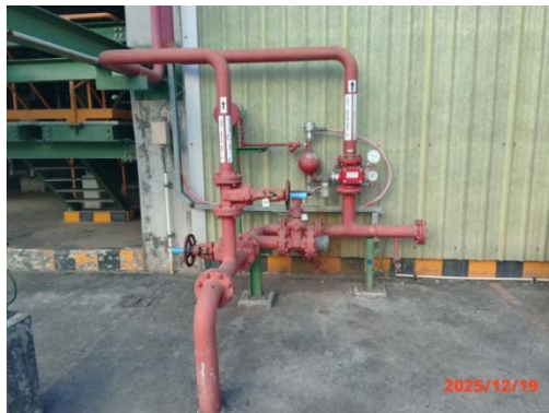
รูปที่ 42 Wet Alarm System
