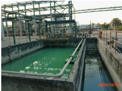
รูปที่ 9 Oil Separator
