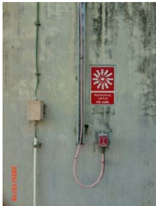
รูปที่ 50 Manual Pull Station
