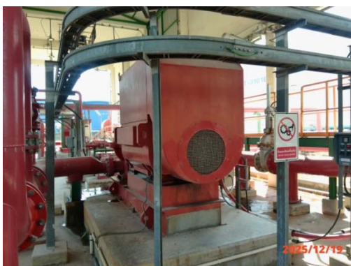
รูปที่ 58 Electric Fire Pump
