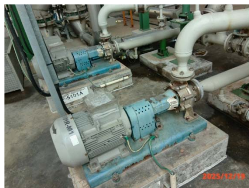
รูปที่ 59 Electric Jockey Pump
