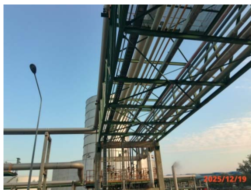
รูปที่ 5 ระบบรวบรวมสารอินทรีย์ระเหยเพื่อนำไปเผาในหอเผาของโรงงานอีเทนแครกกเกอร์
