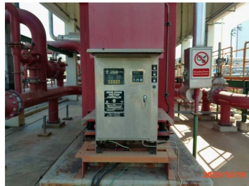
รูปที่ 57 Diesel Fire Pump
