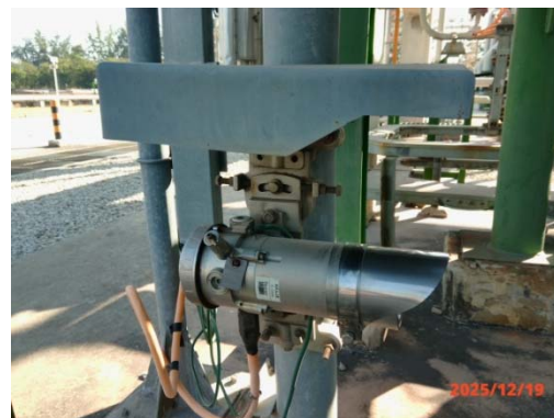
รูปที่ 51 Flame Detector
