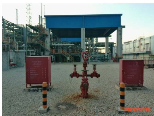
รูปที่ 46 Water Hydrant
