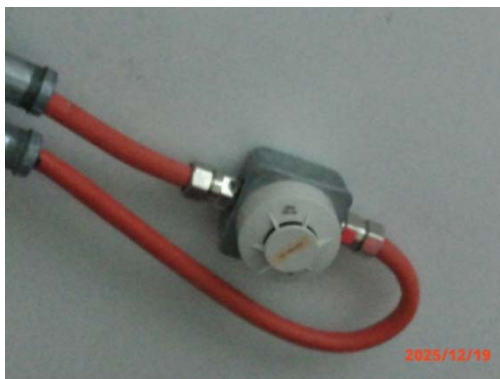
รูปที่ 52 Smoke / Heat Detector
