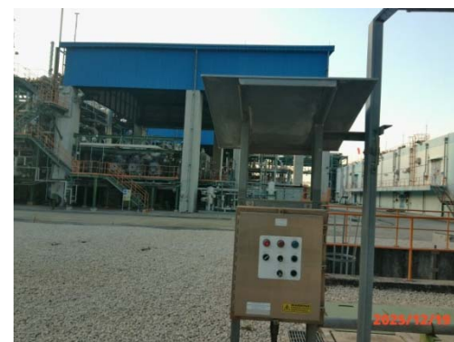
รูปที่ 45 Water Monitor Remote
